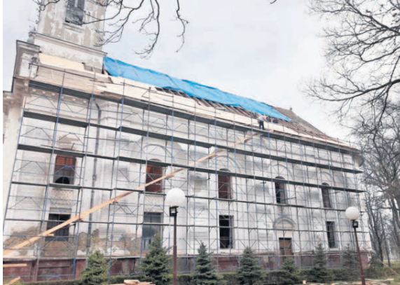
Voll eingerüstet: Der Fortschritt der Renovierungsarbeiten an der Bulkeser Kirche ist sichtbar.
